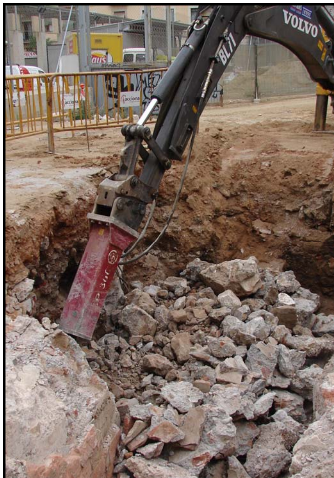
Fig 14. Exemple d'utilització del martell per l'extracció dels murs de fonamentació de formigó.
